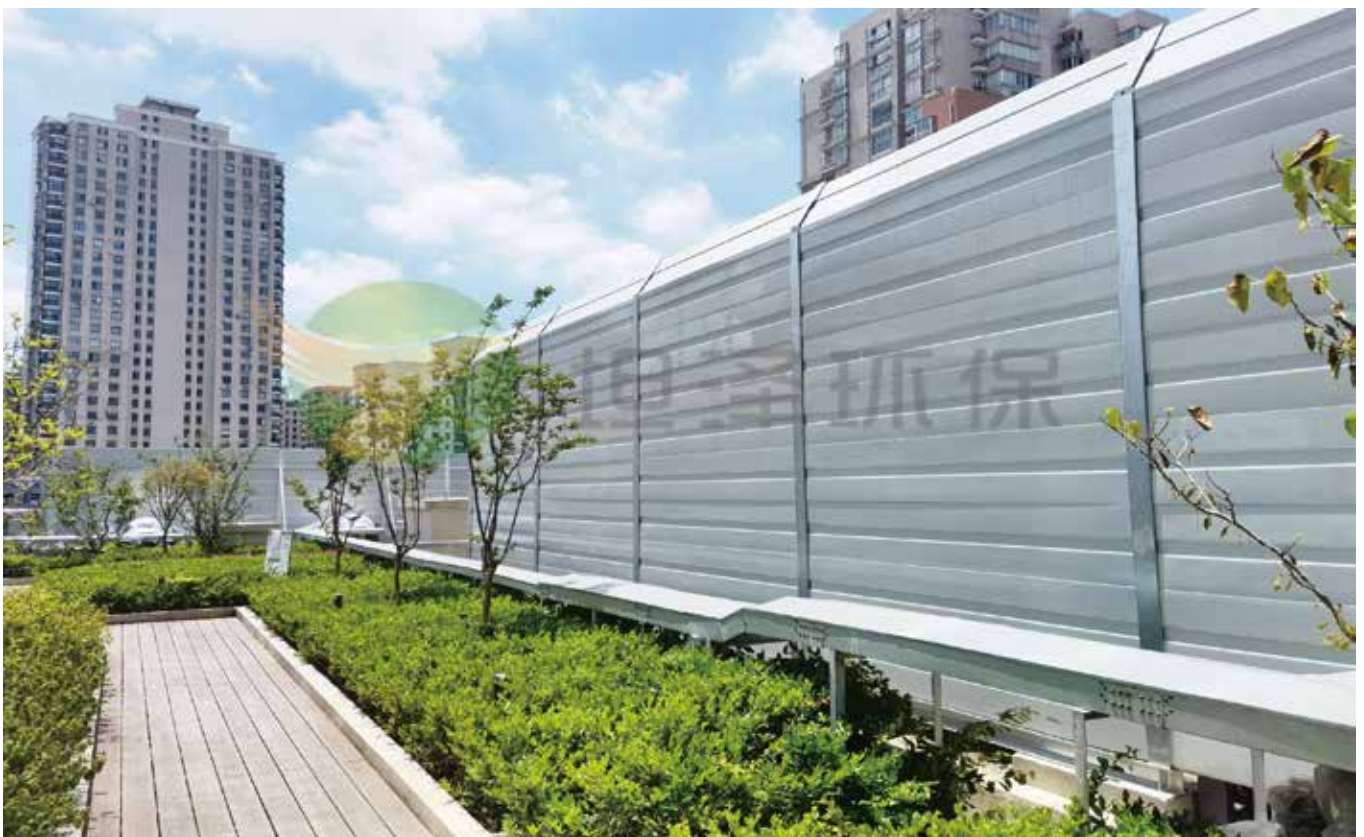
久岸大厦裙楼屋面设备隔音降噪项目
