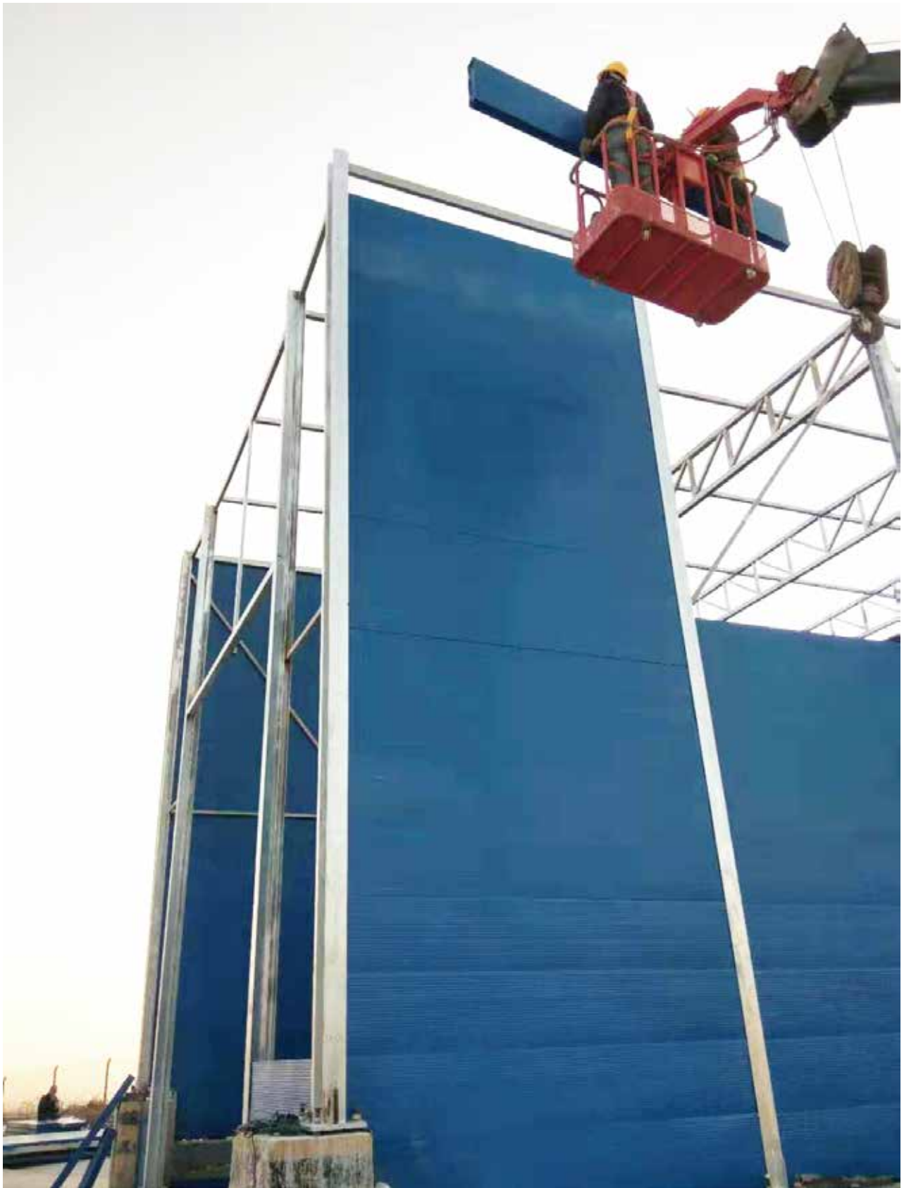
尧柏特种水泥集团-实丰尧柏破碎站隔音降噪项目
