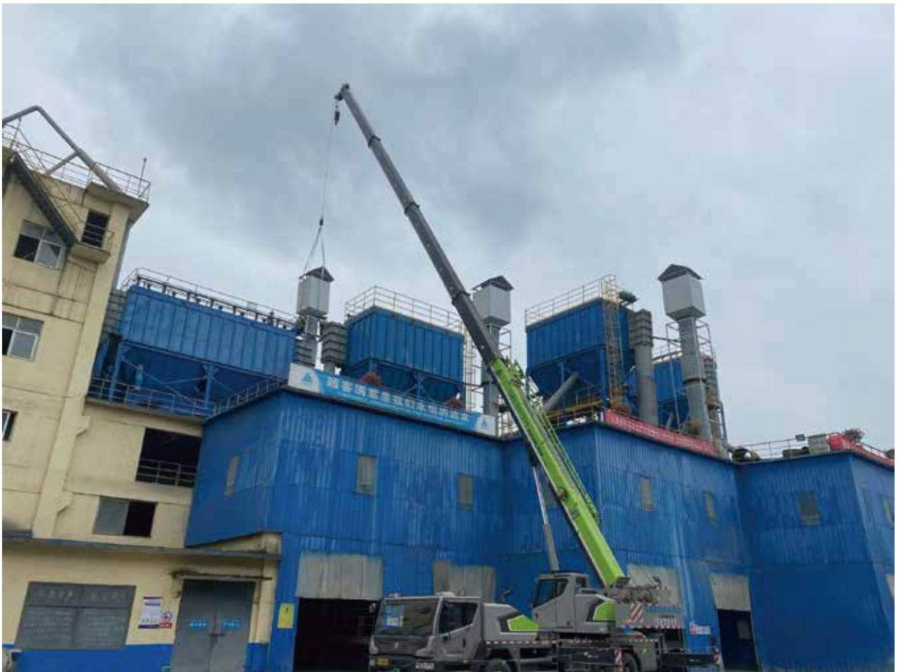
尧柏集团旬阳骨料、渭南尧柏隔音降噪项目
