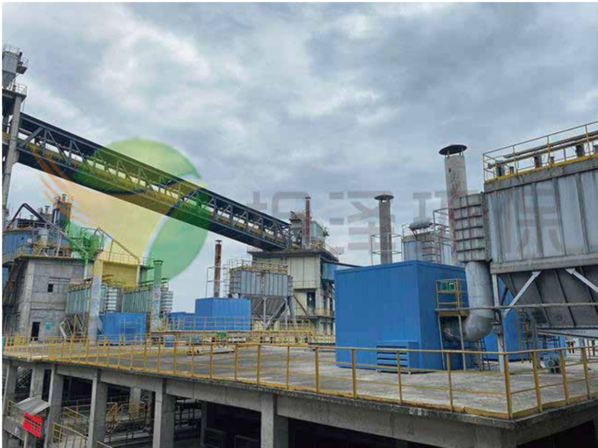
华润水泥（封开）有限公司噪声治理项目
