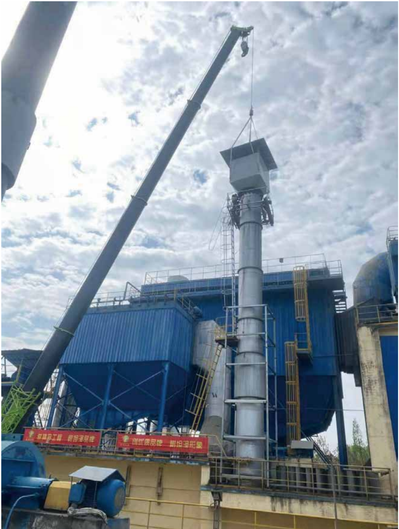
尧柏集团旬阳骨料、渭南尧柏隔音降噪项目
