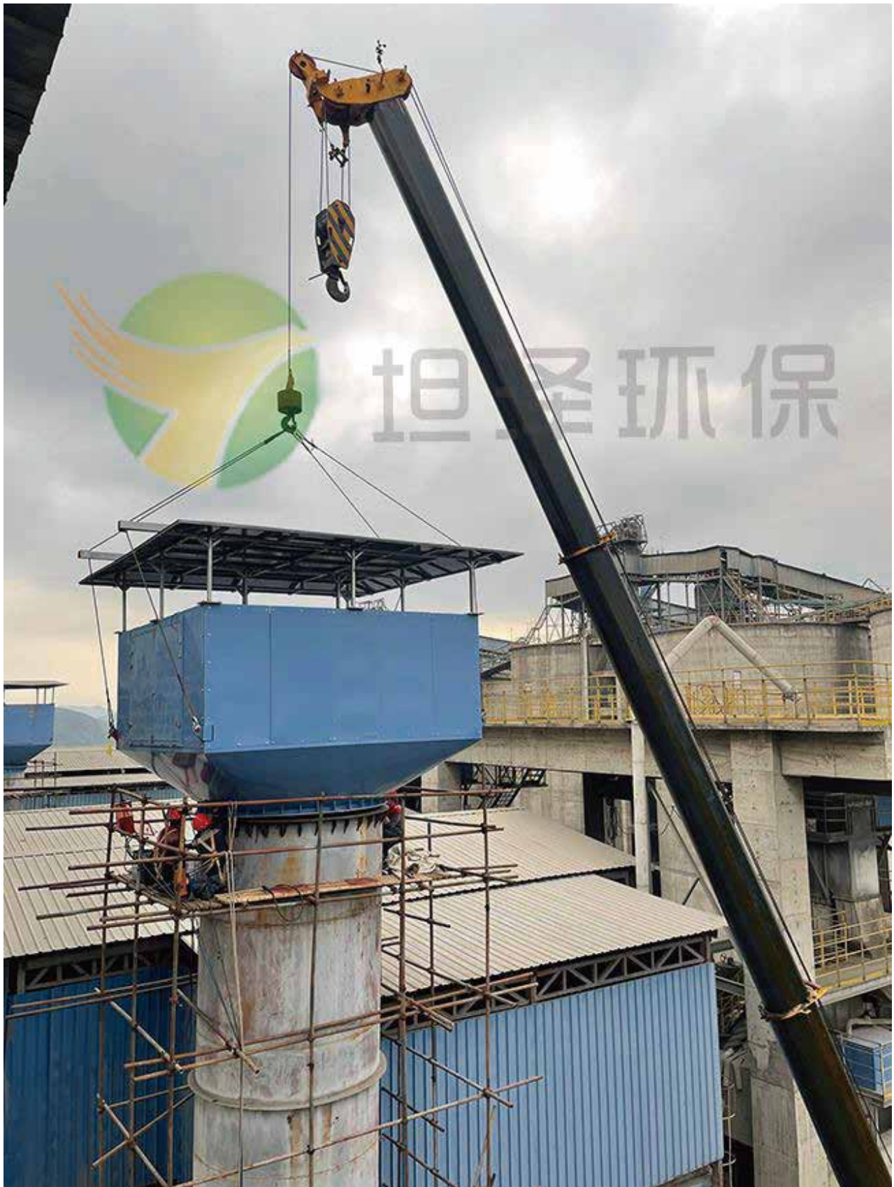
华润水泥（封开）有限公司噪声治理项目
