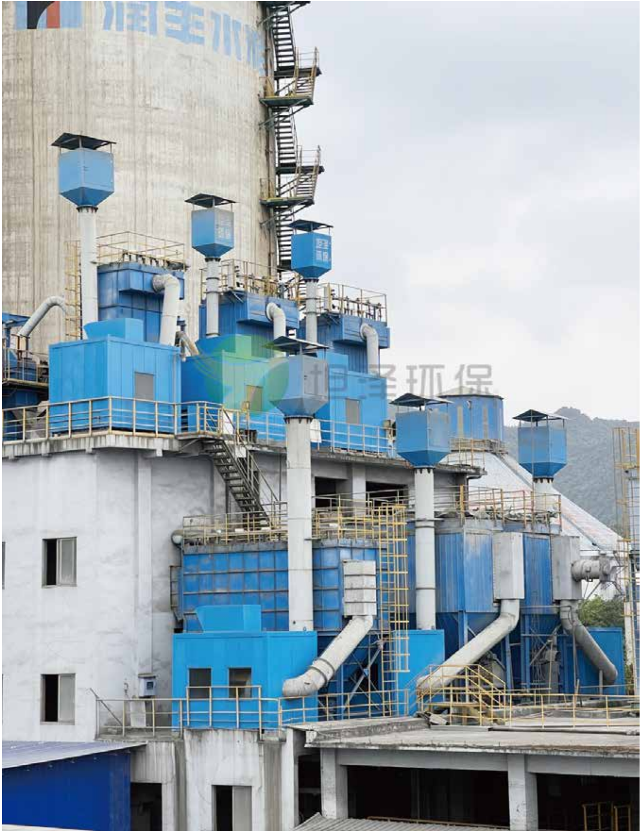
华润水泥（南宁）有限公司噪声治理项目
