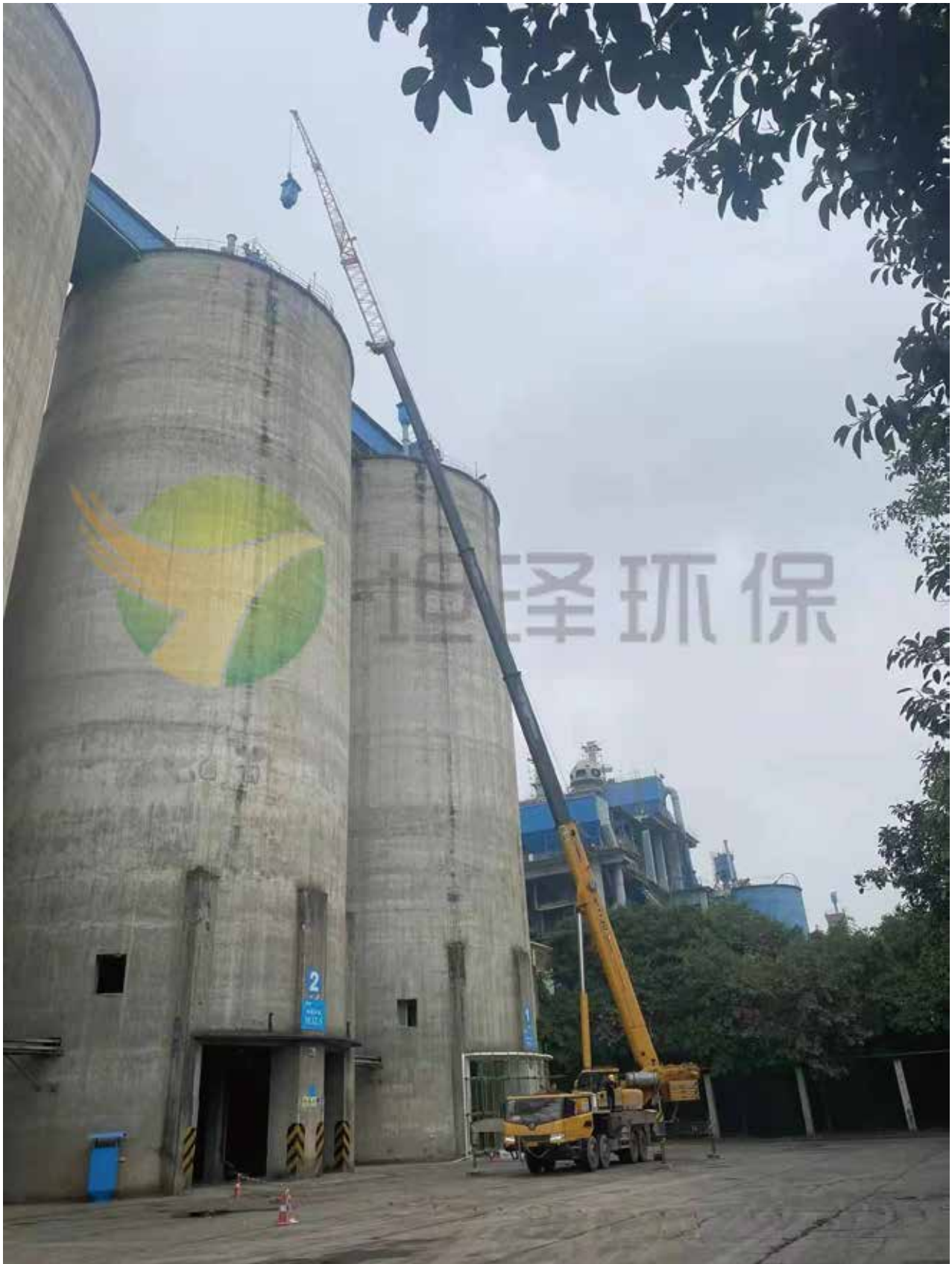
华润水泥（南宁）有限公司噪声治理项目
