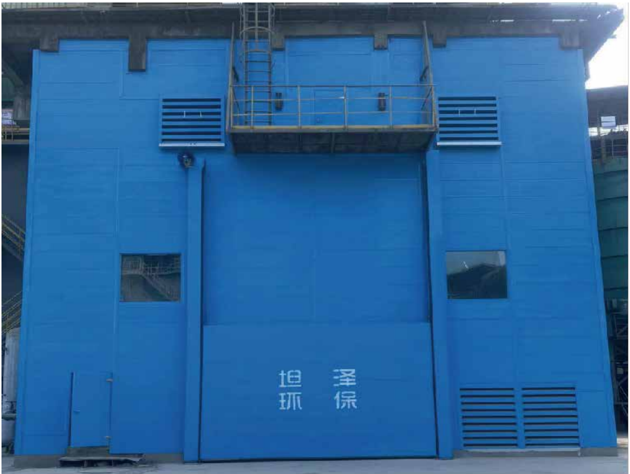
华润水泥（南宁）有限公司噪声治理项目
